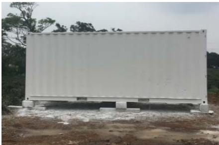
無機隔熱礦粉塗料貨櫃屋節能效益試驗
